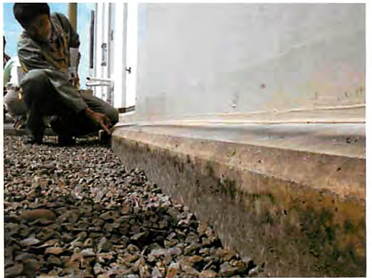
下: 浜岡原発5号機タービン建屋の屋外東側では、外壁に沿った15メートル四方にわたって、地盤沈下が確認された。中電社員の示す高さから最大10センチ沈んだ。09年8月21日
